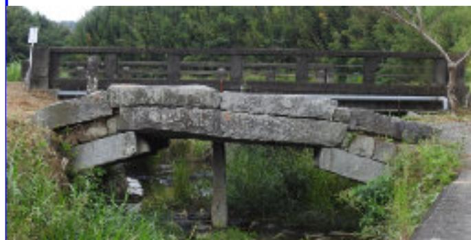
山田の境川にかかる石造りの刎橋（はねばし）。明治16年にかけてられたので橋の名前は十六橋（伝承）。この橋には橋脚がない。両側から斜めにせり出した石柱の上に桁となる石柱がのせてある。この構造の橋を刎橋と呼ぶ。
